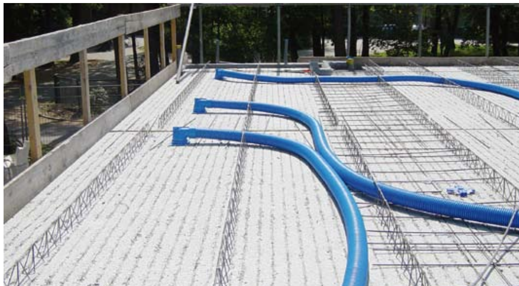
Het drukverlies blijft beperkt bij het werken met aparte ronde kunststof kanalen naar elk rooster.
